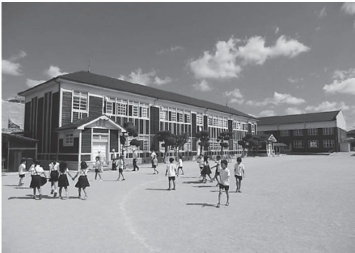
木造の八上小学校校舎
